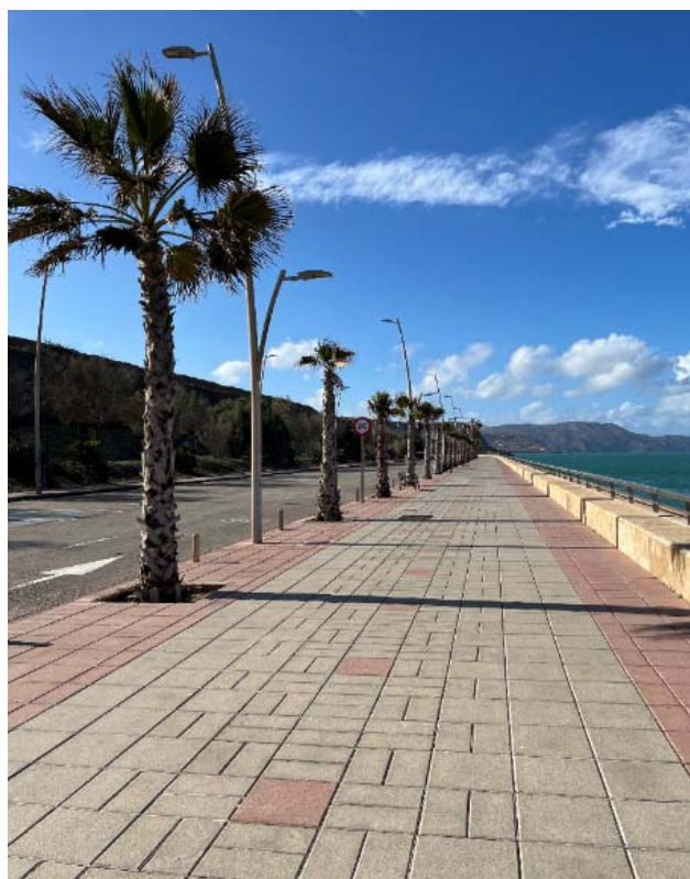
Ilustración 6. Paseo Marítimo de Horcas Coloradas. Fuente: elaboración propia.
