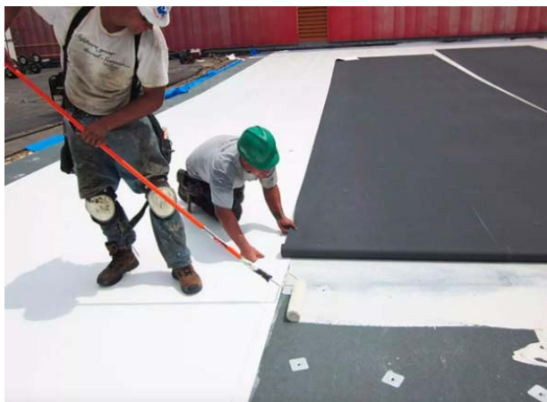
Ilustración 16. Techo frío (pintado de blanco). Fuente: información.es
