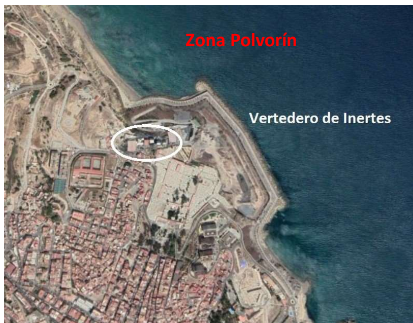
Figura 11. Zona Polvorín y localización del Vertedero de Inertes de Horcas Coloradas en la Ciudad Autónoma de Melilla. Elaboración propia.
