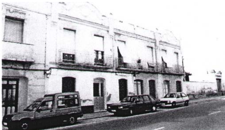
- Carretera Hidum 37 (demolido)
