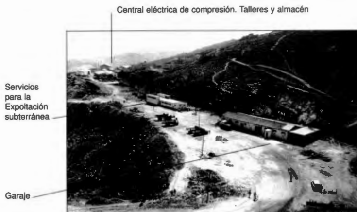
Fotografía 6. Instalaciones del nivel 316 m.
