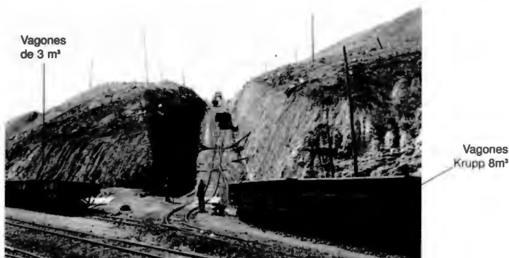
Fotografía 8. Plano inclinado nº 7, y vagones Krupp, de ocho metros cúbicos.
