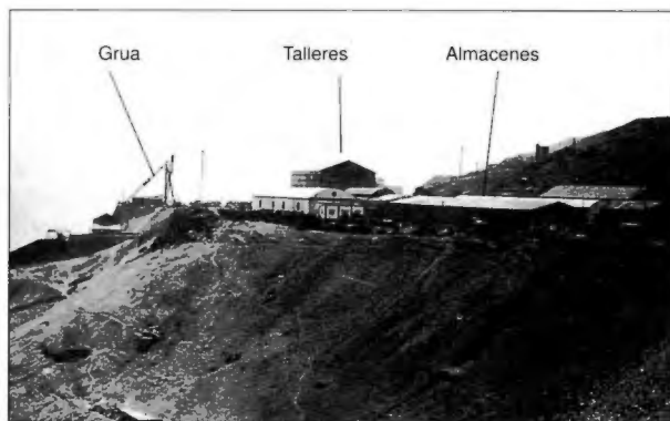
Fotografía 9. Grúa, talleres y almacenes.
