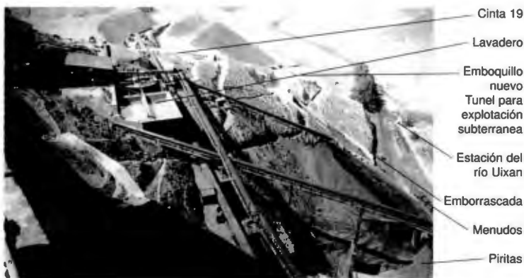
Fotografía 7. Planta de tratamiento y, debajo, estación de ferrocarril del río Uixan.
