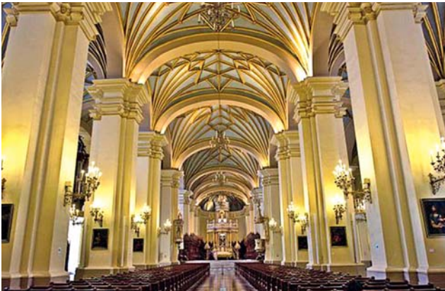
(Figura 9) Nave central de la catedral de Lima. El material más ampliamente usado en la construcción de las bóvedas es la madera y la quincha (especie de adobe con alma de caña), al objeto de evitar los daños que los frecuentes terremotos producen en la mampostería convencional.
