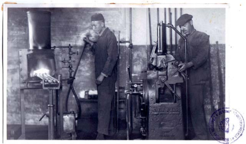
(Figura 3) Proyecto de adquisición de una instalación de aire comprimido para las canteras de Melilla. Pascual de Luxán y Zabay, ingeniero. Archivo Histórico Provincial de Málaga 25235/16.
