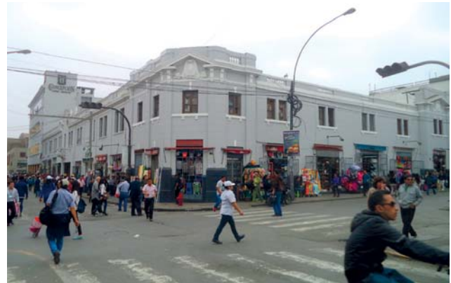
(Figura 6) Actual esquina Sur de la propiedad, entre los jirones Ucayali y Andahuaylas.
