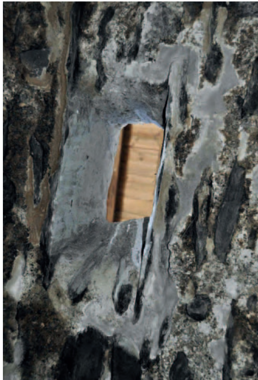
(Figura 2) Reintegración de Lucerna de la Bayt al-sajun (JGG).
