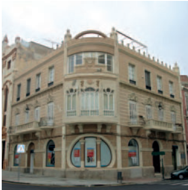
(Figura 6) Fachada de El Telegrama del Rif. Arq. E. Nieto, agosto 1912 (21 agosto 2011, SGA).
