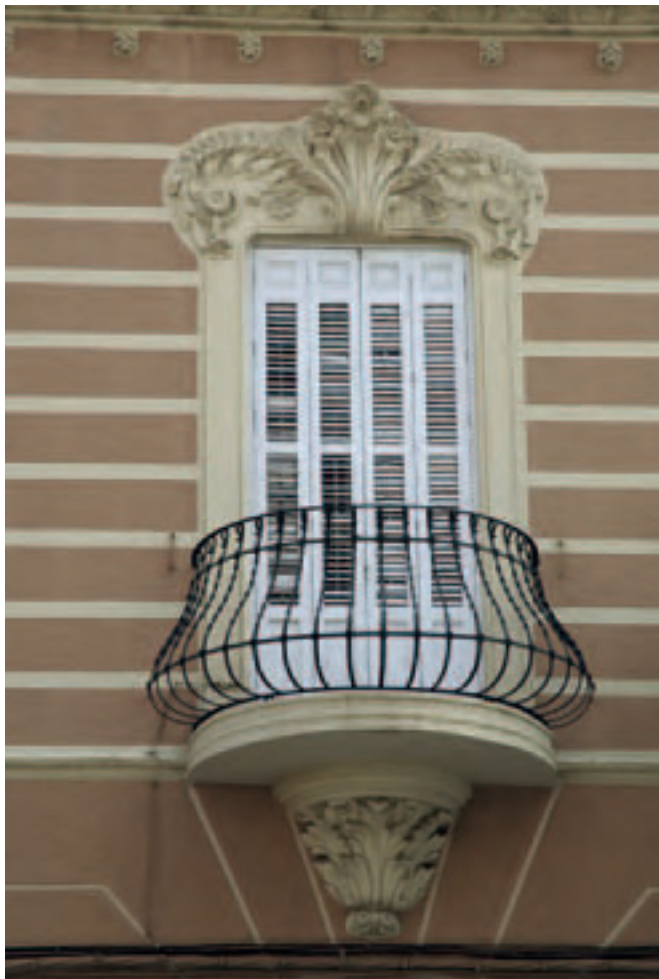
(Figura 7) Edificio de El Telegrama del Rif . Detalle (9 agosto 2005, SGA).
