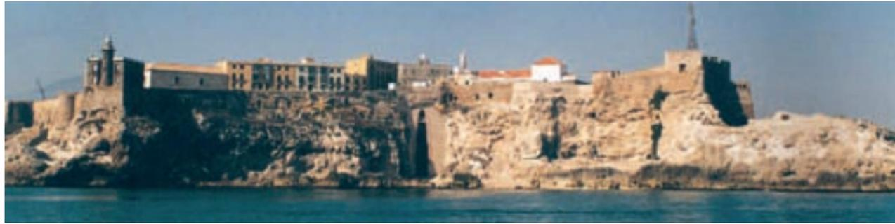
(Fig. 1) Panorámica de la muralla de las Cruces desde el mar. Foto: Soria, 1996. Se había construido el arco parabólico y reparado el derrumbe del extremo Norte. Faltaba restaurar el tramo central de las cuevas y construir la escalera de acceso a la cala de Trápana.
