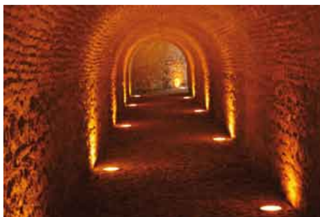
Estado actual Túnel.
