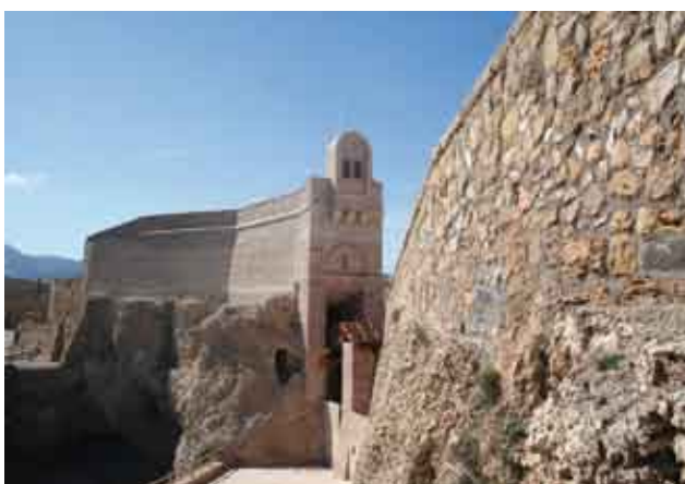
Estado actual flanco Este.
