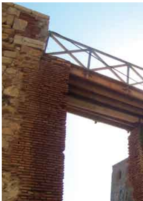
Estado anterior y actual del puente.
