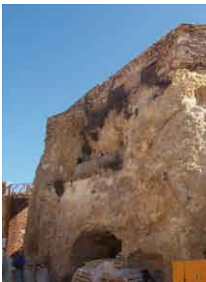
Estado anterior flanco Oeste.
