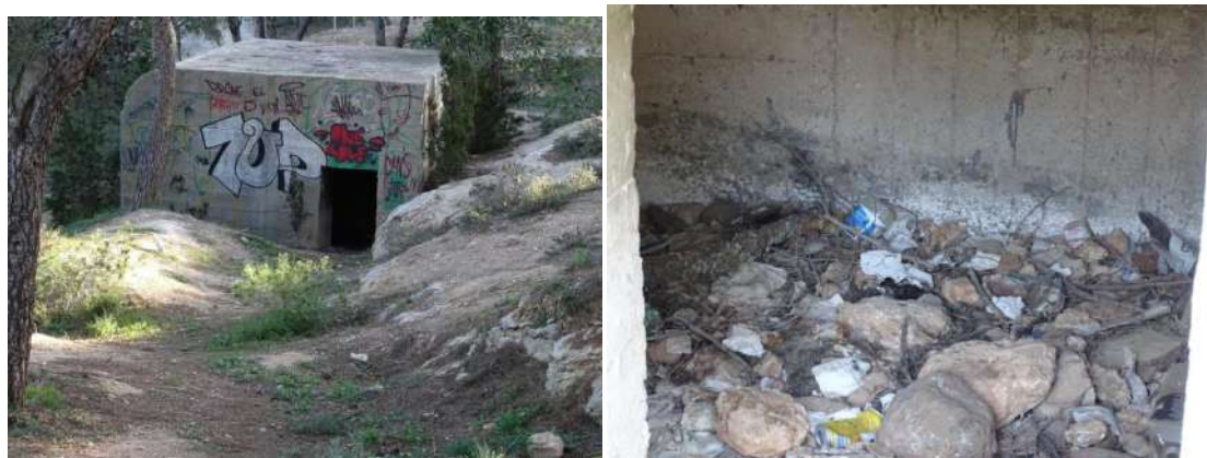
Figura 12. Bunker abandonado en el Quemadero
