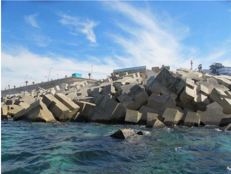
Bloques de la escollera de Horcas
