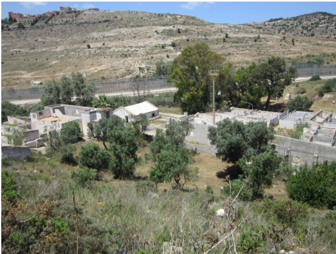
Imagen 4: Parcelas sin acceso en recinto cuartelario.
