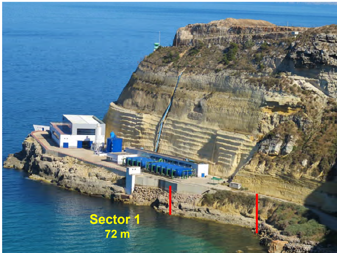
Figura 41. Primer tramo de la ZEC junto a la desalinizadora
