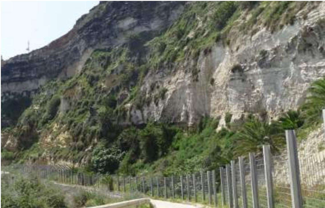
Aspecto general de la zona 1
