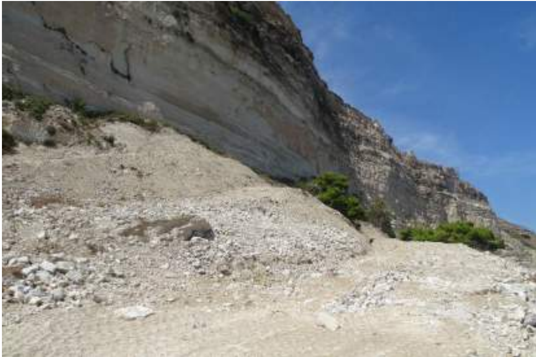
Aspecto parcial de las obras el 5-IX-2023
