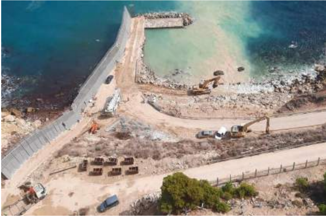
Parte final de la zona 4: estado de las obras el 9 septiembre 2024
