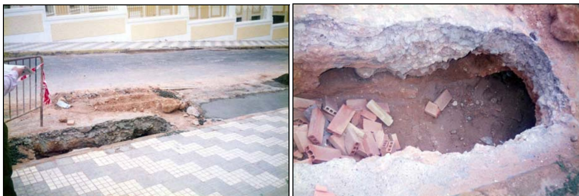
Zanjas para introducir el cableado realizado en la calle Cándido Lobera.
