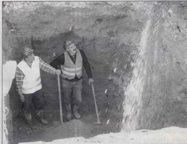
Los trabajadores de la empresa encargada del soterramiento estaban excavando cuando se encontraron los huesos humanos
