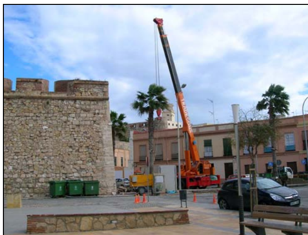
Inicio de los trabajos de soterramiento.
