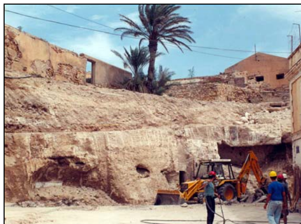
Fotografía de las obras desarrolladas (1995).
