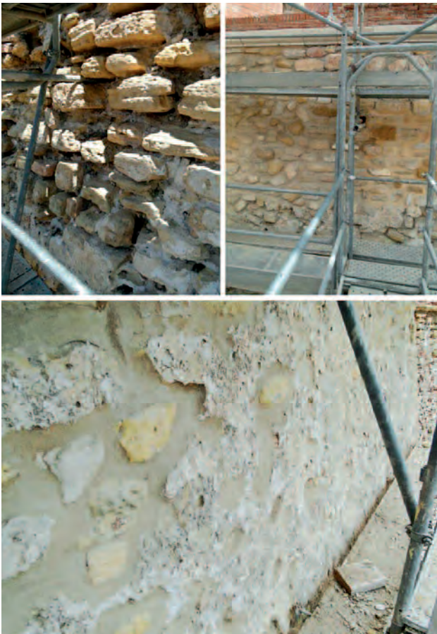
(Figura 4) Llagueados y consolidación de paramentos y enfoscados originales.
