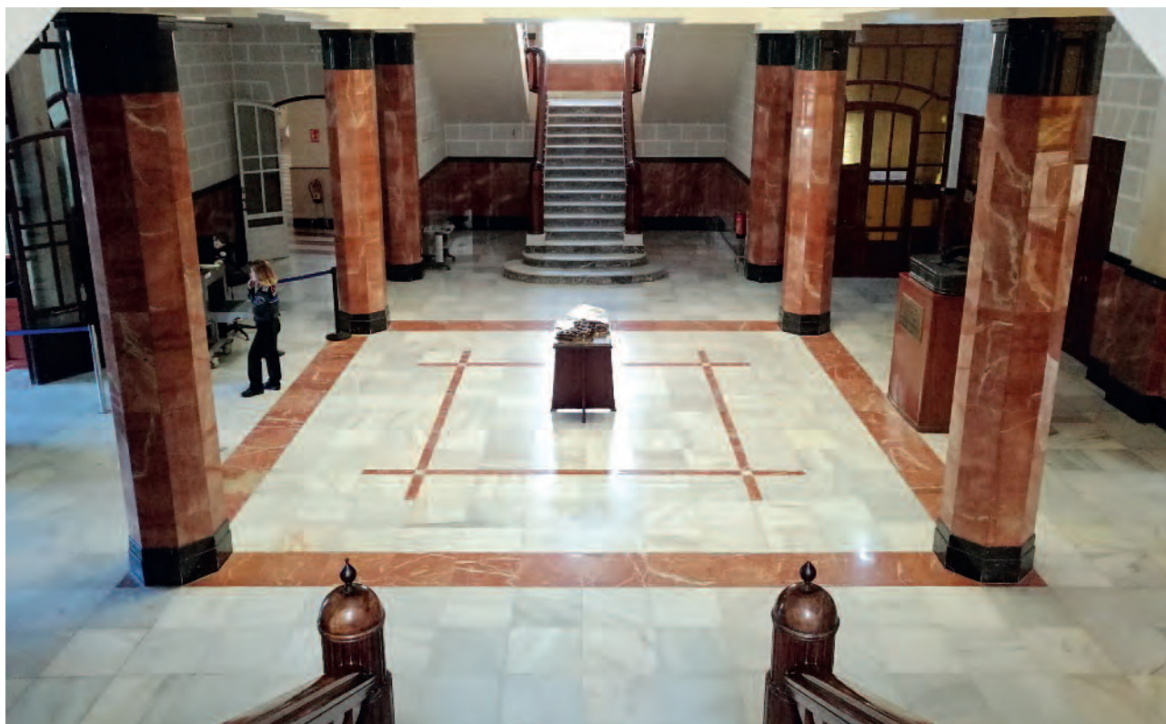
(Figura 6) Reparación pilares y resto vestíbulo central.
