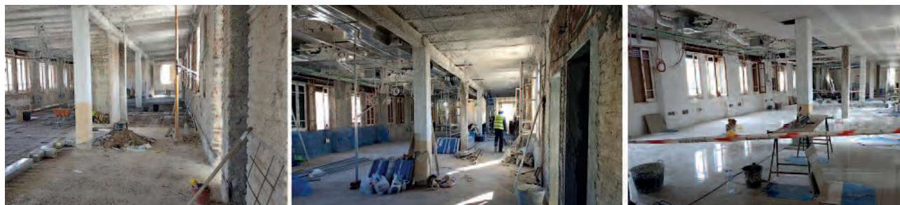
(Figura 7) Paso 2. Reparar: Comienza la ejecución de la capa de compresión. Se aprecia también el comienzo de los trabajos en instalaciones. Ejecutada capa de compresión, se avanza en instalaciones y se reparan muros. Ejecutada nueva solería y acabados en muros. Ejecutándose falsos techos. Continúan trabajos en instalaciones.
