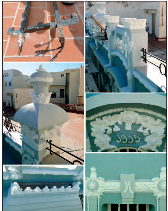
(Figura 6) Cerrajerías y acabados. Aplantillado de fachada.
