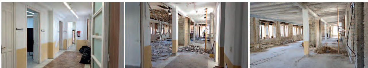
(Figura 6) Estado previo. Paso 1- Demoler: retirada de falsos techos y tabiquería. Aún se aprecia la solería y acabados en muro previos al terremoto. / Paso 2 - Reparar: se observa la completa demolición de tabiquerías y la retirada de solería y acabados. Se comienza a ignifugar forjados.
