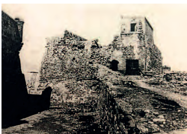
(Figura 2) Acceso en rampa al fuerte.
