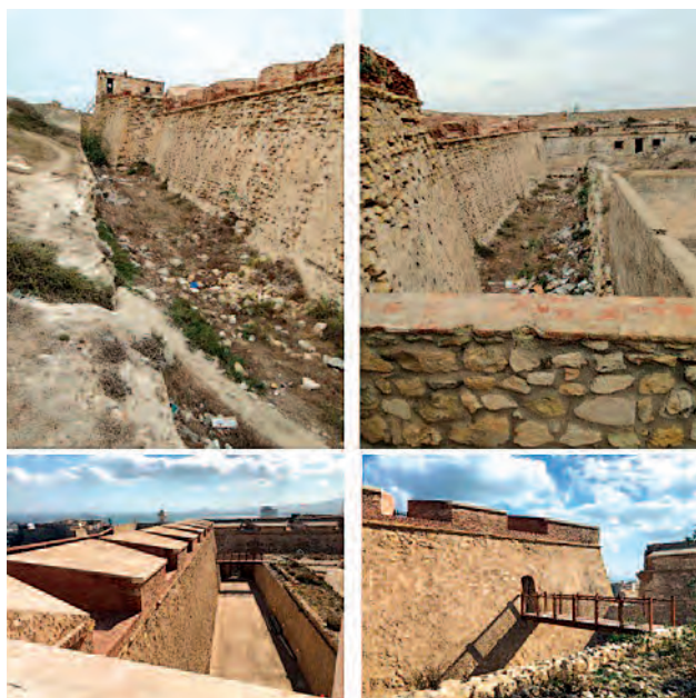
(Figura 6) Cara Oeste del Fuerte antes y después de la intervención.
