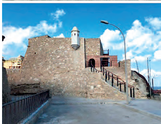
(Figura 8) Paramento más dañado. Cara Sur del Fuerte antes y después de la intervención.
