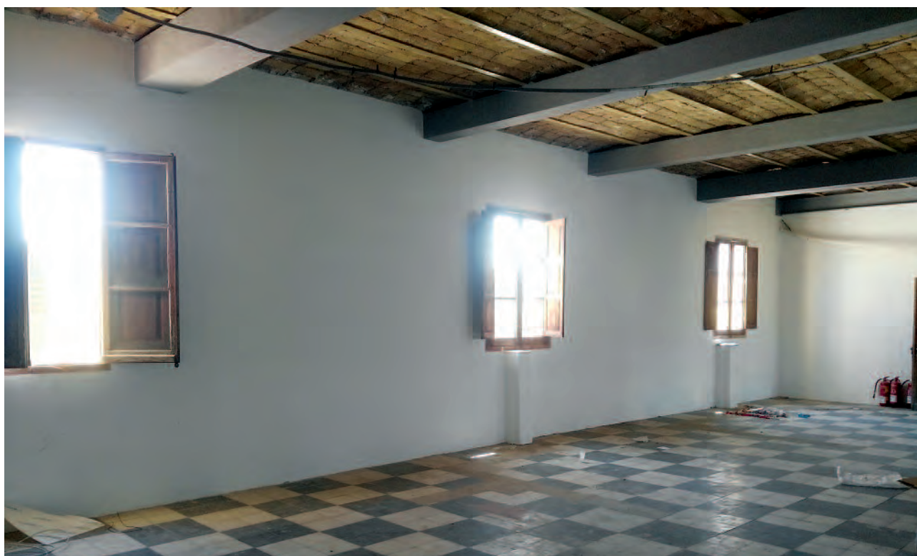
(Figura 8) Sala del reloj una vez reforzada.
