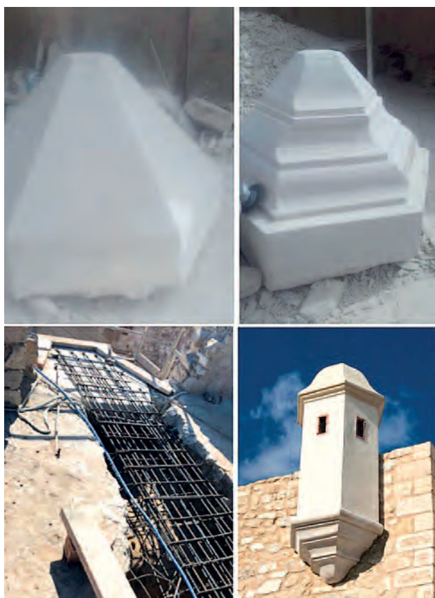
(Figura 7) Proceso de tallado de garita. Anclaje y finalización.
