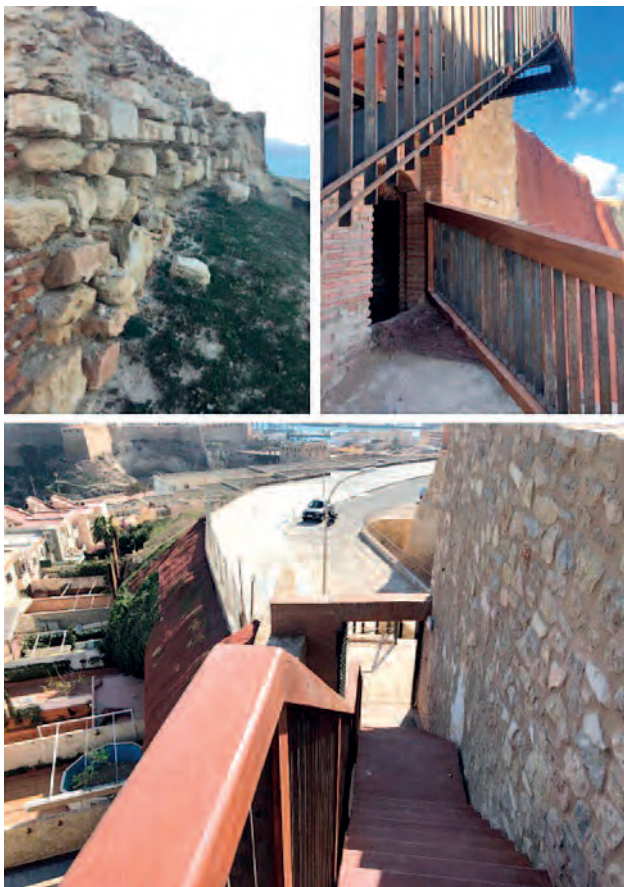
(Figura 9) Escalera volada de acceso en sustitución de rampa sobre el cuerpo de guardia.
