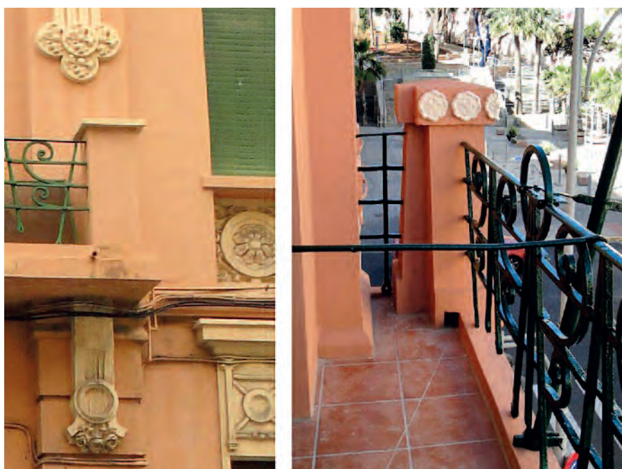
(Figura 12) Reconstrucción de pilastra de bancón.
