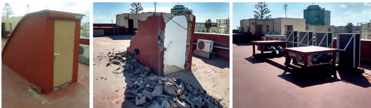
(Figura 10) Evolución en trabajos de cubierta. Nueva maquinaria de climatización.
