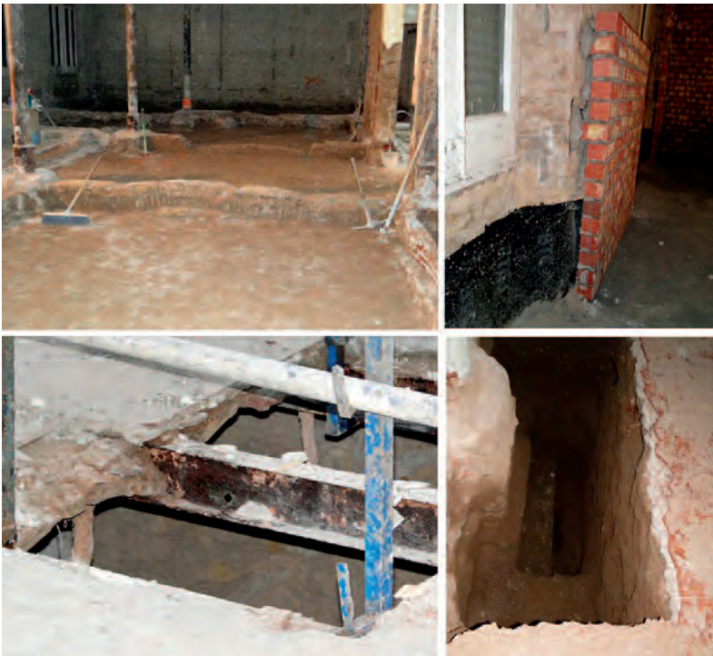
(Figura 9) Refuerzo en cimentaciones y muros.
