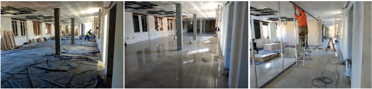
(Figura 8) Paso 2. Reparar: Concluidos trabajos de adecuación de pilares. / Paso 3. Ordenar: Concluidos trabajos de reparación. Un gran espacio diáfano listo para la distribución de espacios modulares. Ejecución de tabiquerías modulares.
