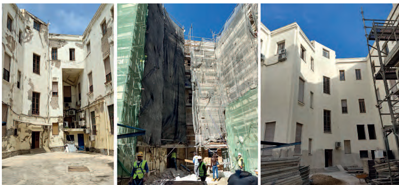
(Figura 3) Evolución de fachada trasera. Se hace hincapié en eliminar maquinaria de climatización. Se observa el nuevo espacio para el aseo de planta primera.
