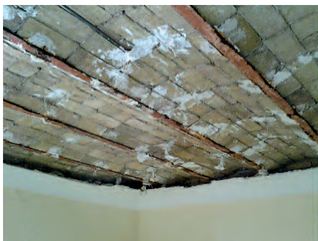
(Figura 5) Estado previo frente a estado final de las viguetas del castillete de escaleras.
