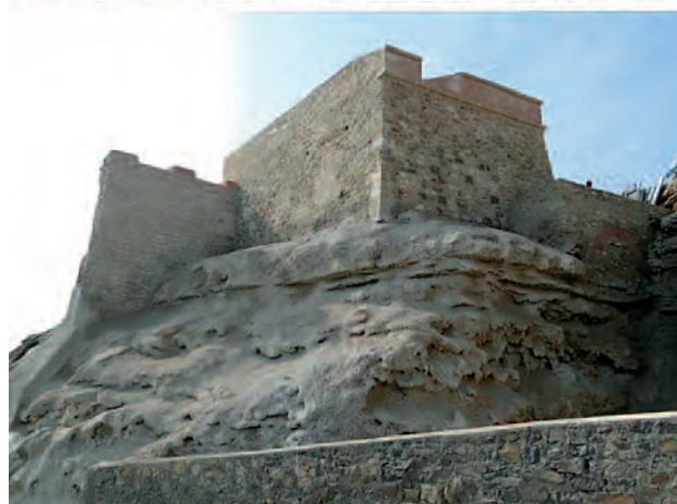
(Figura 3) Cabecera Norte del Fuerte antes y después de la intervención.
