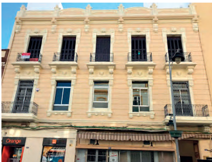
(Figura 13) Fachada del edificio rehabilitada.
