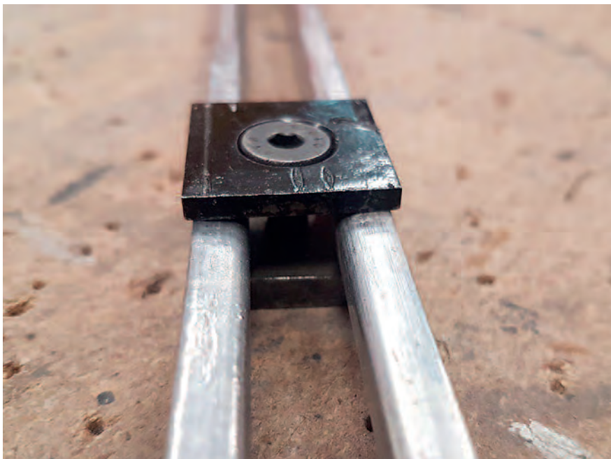
(Figura 6) Detalle explicativo: piezas del sistema AiVi agarrando el refuerzo de latón.
