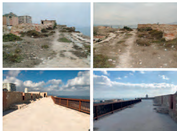
(Figura 10) Cubierta del Fuerte. Antes y después de la intervención.
