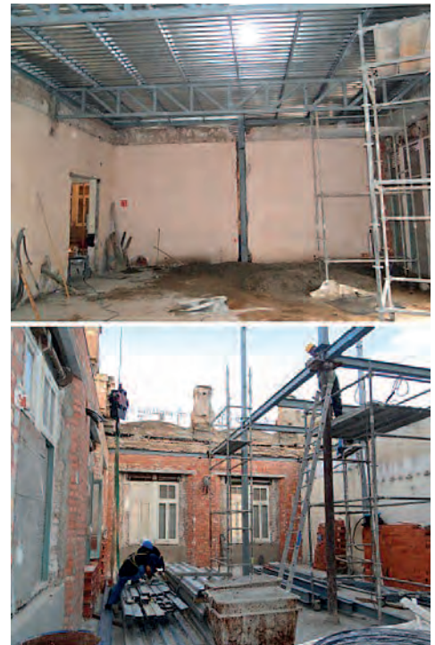
(Figura 10) Estructura ampliada. Cubierta ligera.
