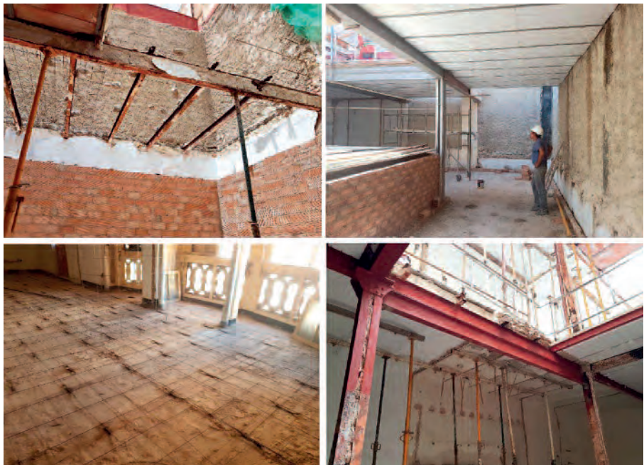
(Figura 19) Forjados rehabilitados.
