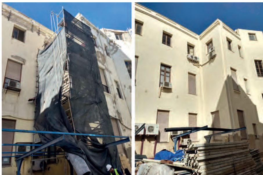
(Figura 4) Evolución de la retirada del aseo de planta primera.
