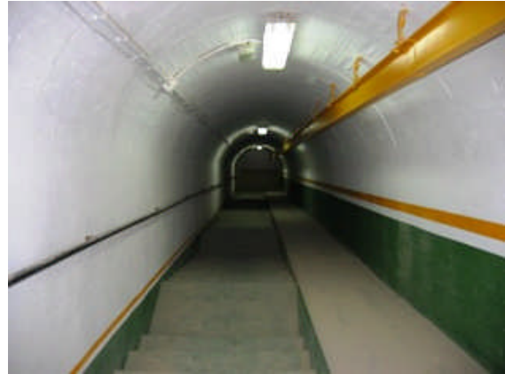
Bajada al sondeo
