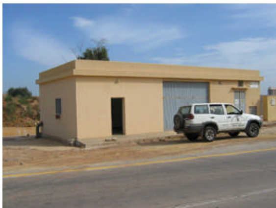
Panorámica desde la carretera perimetral
