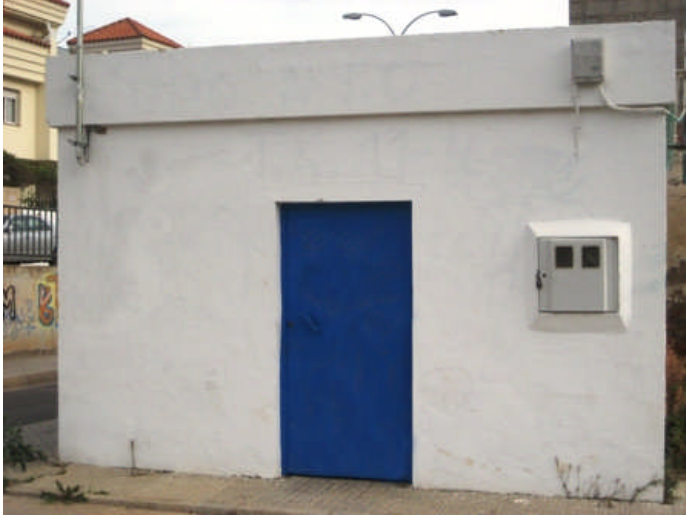
Entrada al pozo
