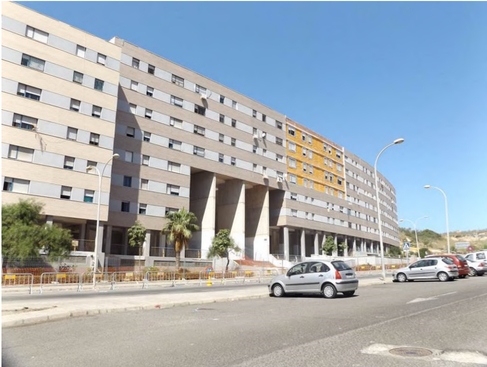
Fotografía nº 6 – Vista general Bloques nº 11 a 19, fachada este a Ctra. Tiro Nacional
