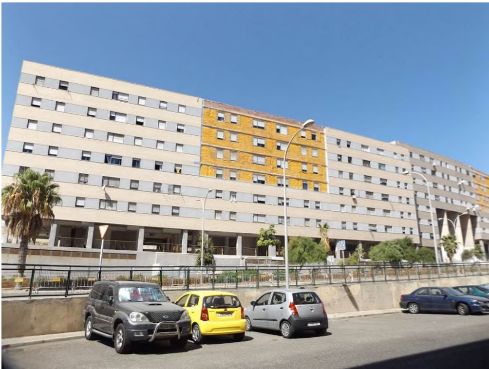
Fotografía nº 5 – Vista general bloques nº 5 a 9, fachada este a Ctra. Tiro Nacional
