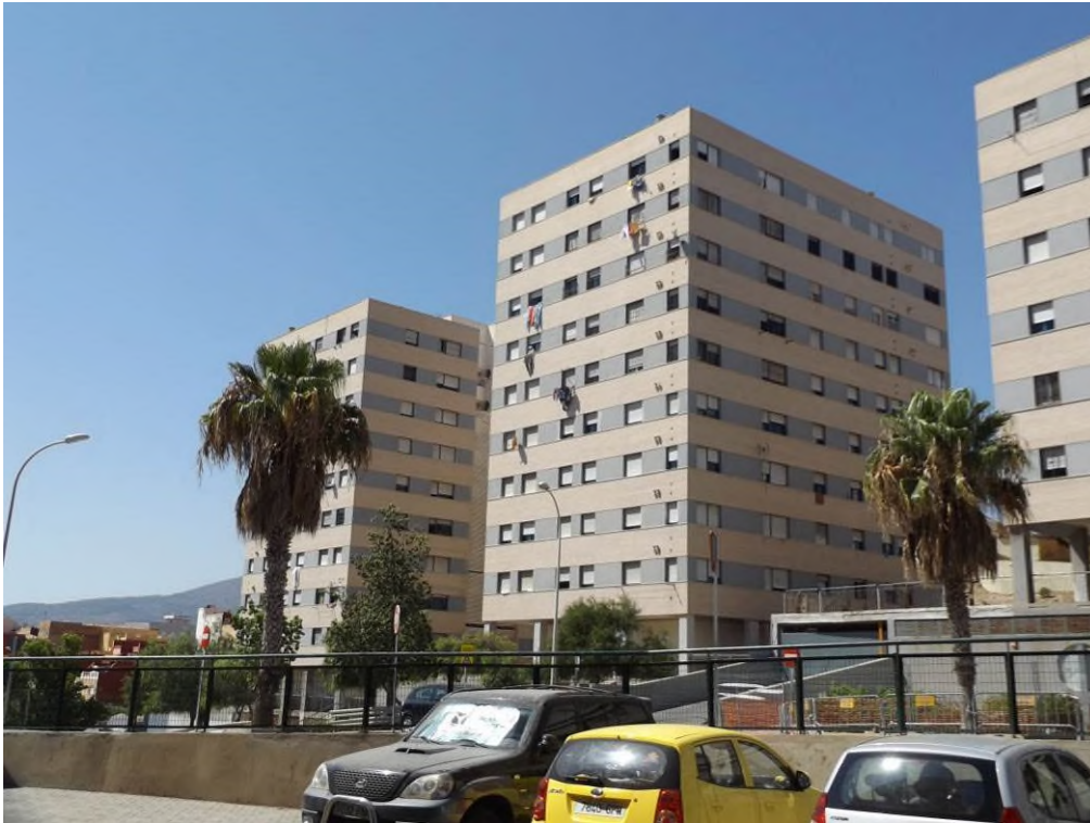
Fotografía nº 4 – Vista general bloques nº 1 y 3, fachada este a Ctra. Tiro Nacional
