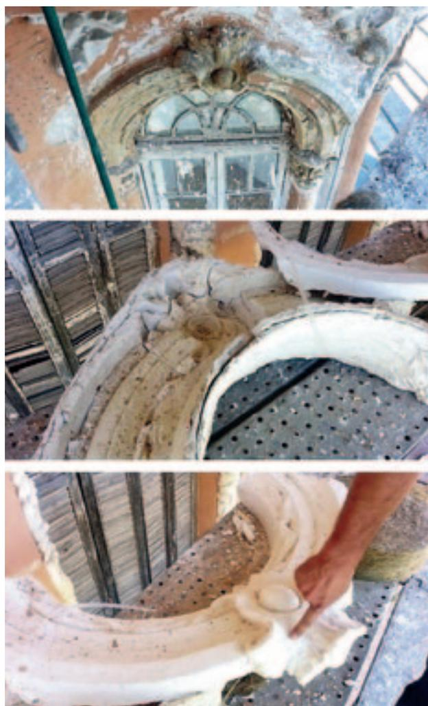
(Figura 5) Obtención de réplica de moldura en escayola de la que se sacarán los moldes.
