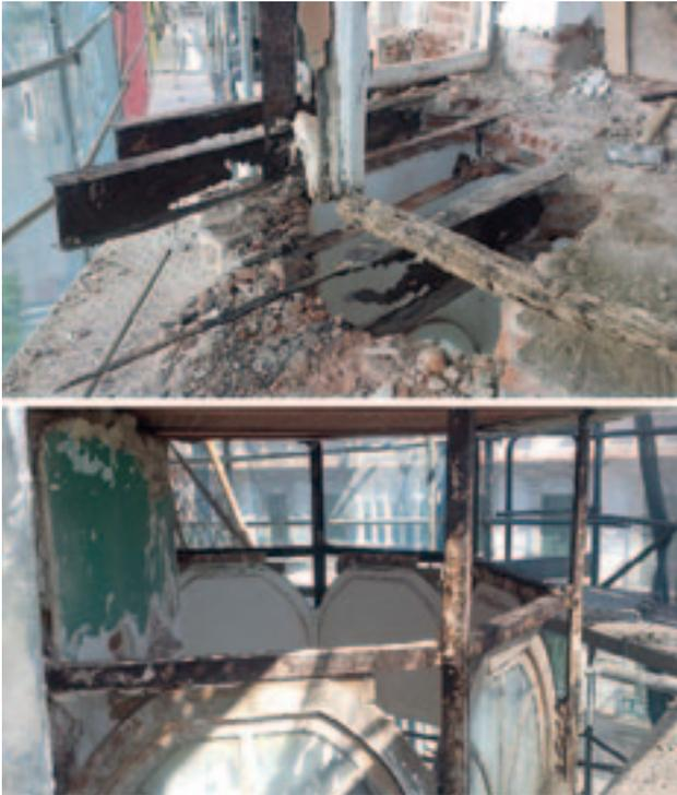
(Figura 6) Estructura de miradores de esquina antes de reposición y refuerzo.
