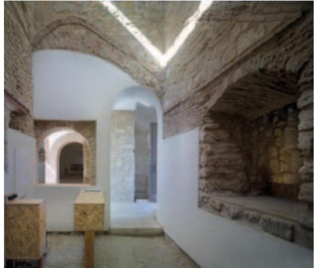
(Figura 4) Antigua apertura en Bóveda de Gola realizada para dar acceso al pabellón del Alcaide de la prisión.
