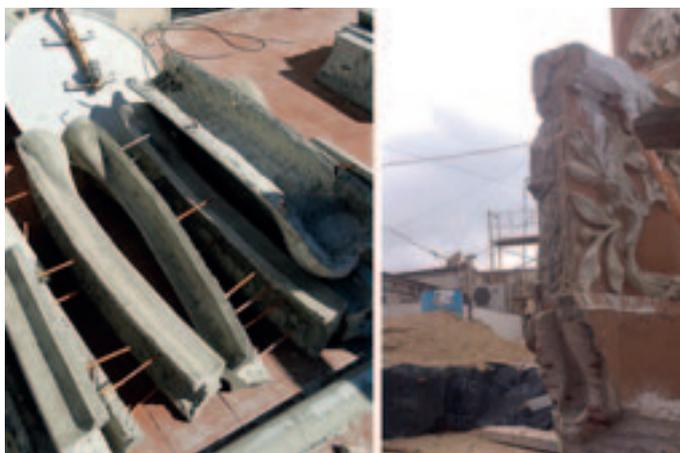
(Figura 9) Obtención de base de columnas de templete.
