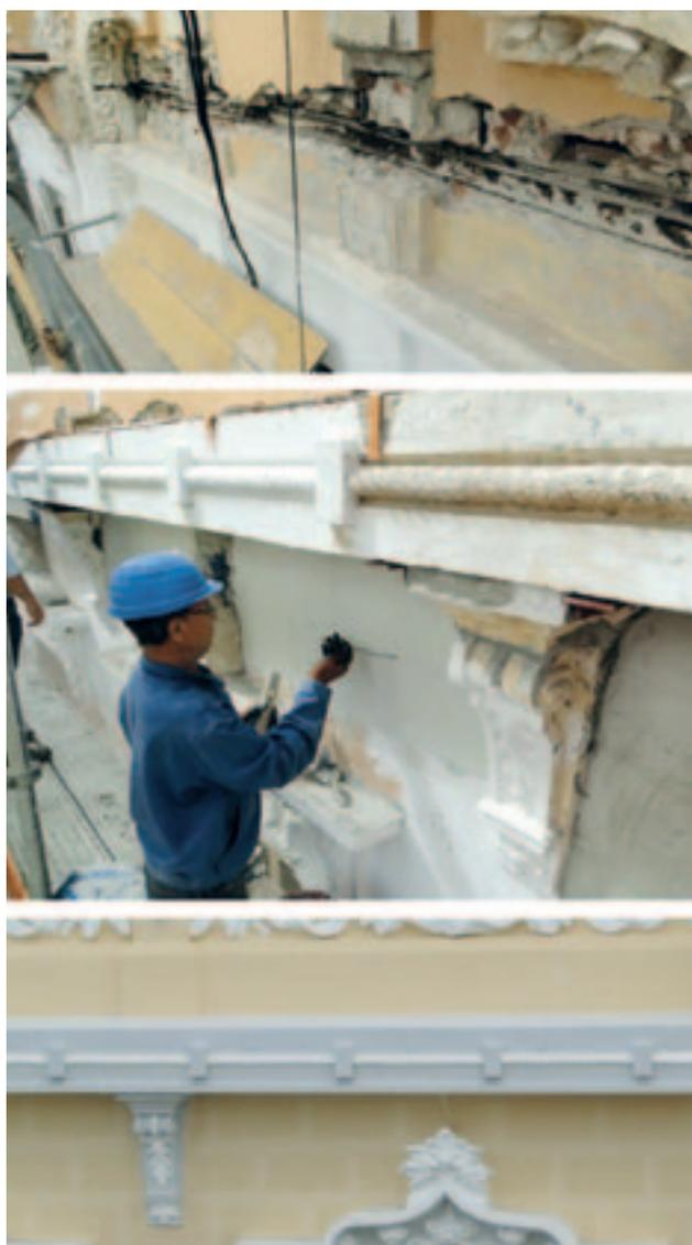
(Figura 8) Proceso de rehabilitación de viga.
