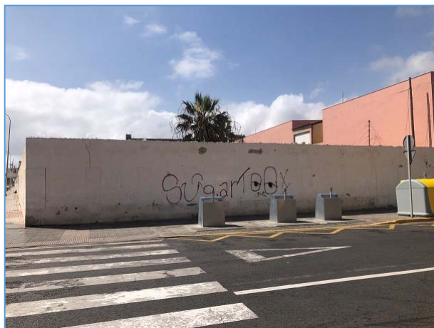
Fotografía 2: Muro del antiguo Club de Tropa.
