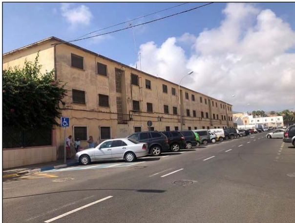
Fotografía 4: Antiguas viviendas (abandonadas).
