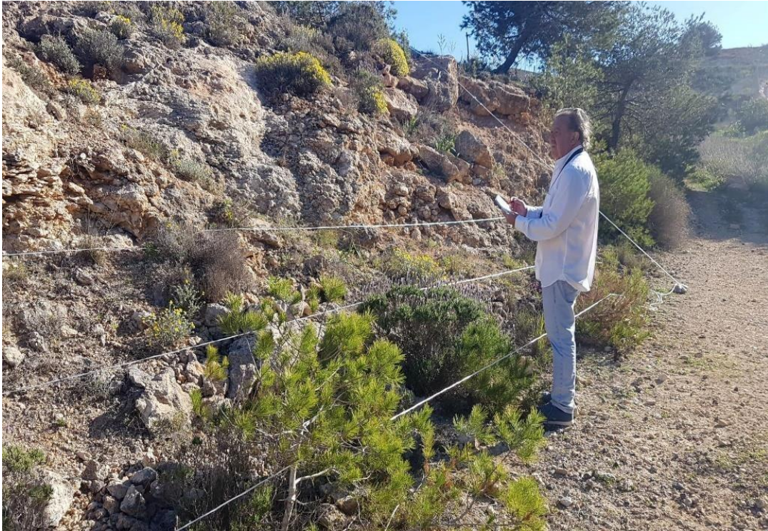
Figura 18. Talud de elevada pendiente
