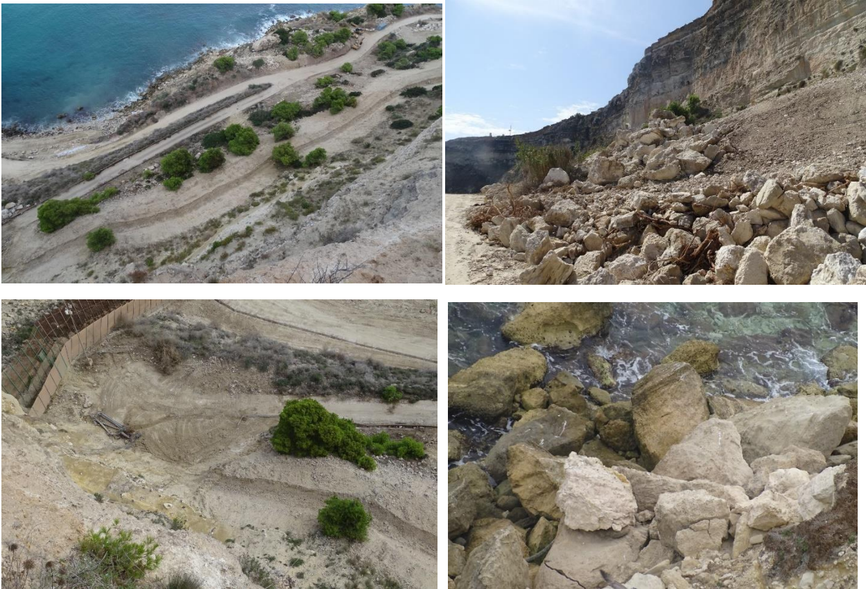
Figura 47. Diversos aspectos de las obras en noviembre de 2023
