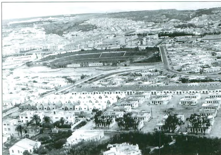
Grupo de viviendas "Operación Ladrillo". Al fondo estadio "Álvarez Claro". 1968
