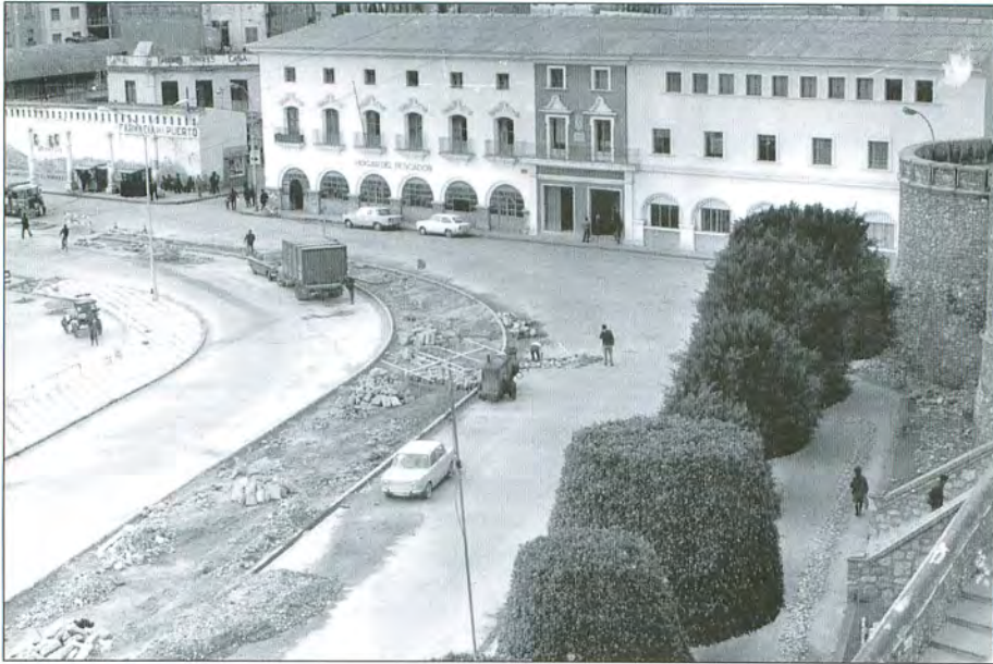
Estado de las obras de acceso al puerto. 1968
