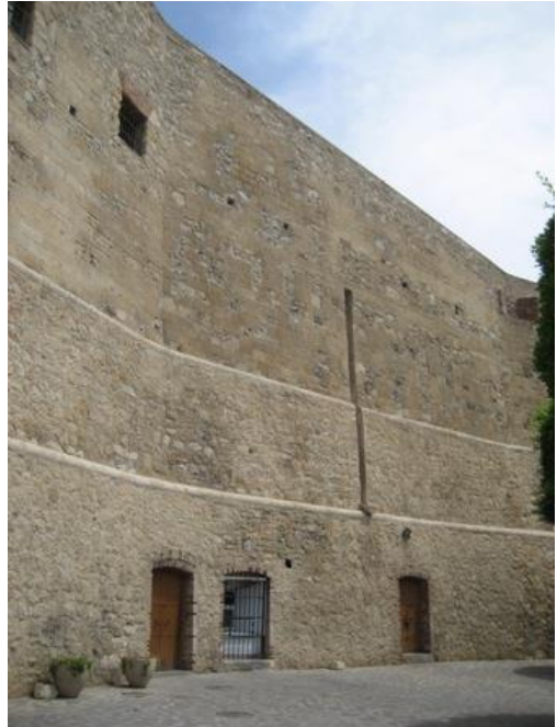
Entre torreón San Juan y puerta de la Marina
