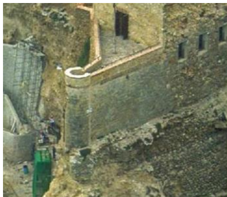
Obras de consolidación del torreón y muralla
