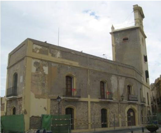
Torre de la Vela (En proceso de restauración)
