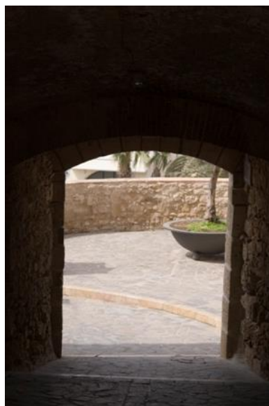
Túnel de la Marina al torreón de la Cal
