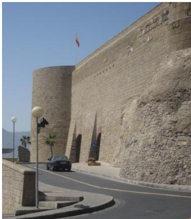
Subida al túnel de la Florentina, al fondo el torreón de Las Cabras
