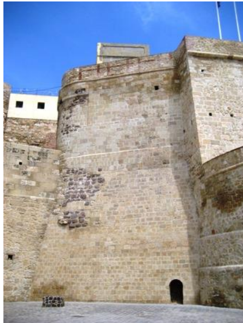
Entre puerta de la Marina y torreón de las Beatas
