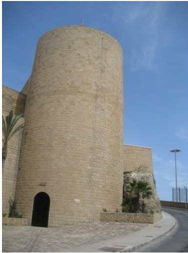
Entrada al ascensor
