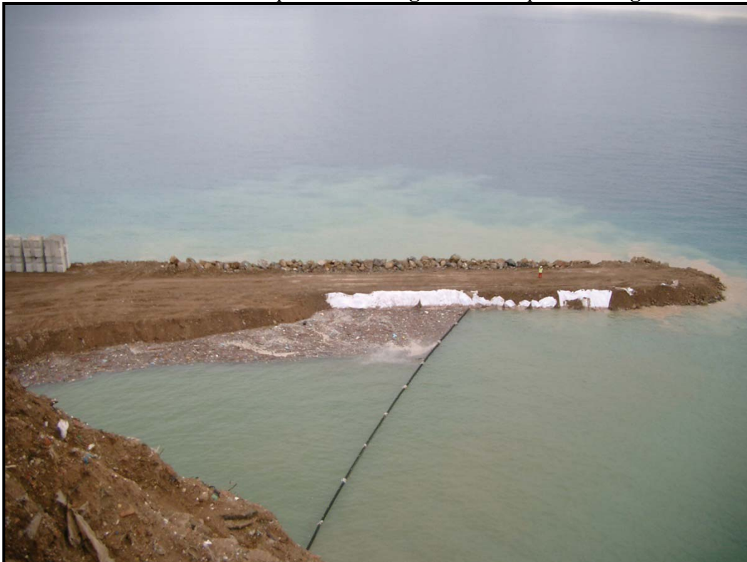
Relleno del terreno ganado al mar
