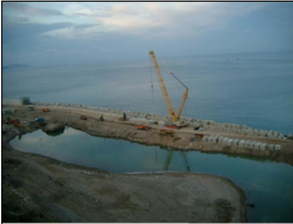
Colocación de bloques de hormigón en el dique de abrigo.
