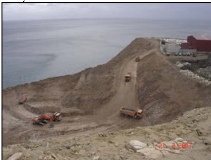
Inicio de las obras, con la construcción de nuevos accesos
