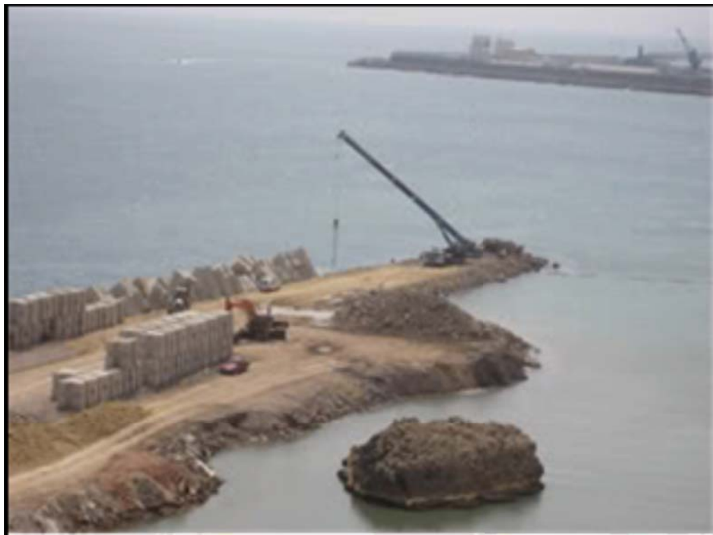
Avance de las obras de los diques de abrigo.
