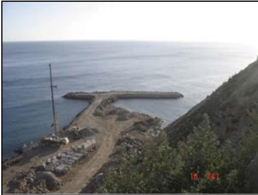
Inicio de la construcción del espigón de abrigo.
